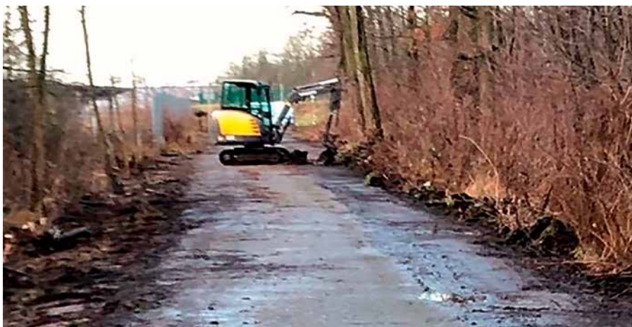
Mit dem Beginn des neuen Jahres wurden erste Veränderungen sichtbar, denn der Bauhof nutzt die Wetterlage, um vorgesehene Rettungswege zu den Seen für große Einsatzfahrzeuge besser befahrbar zu machen
